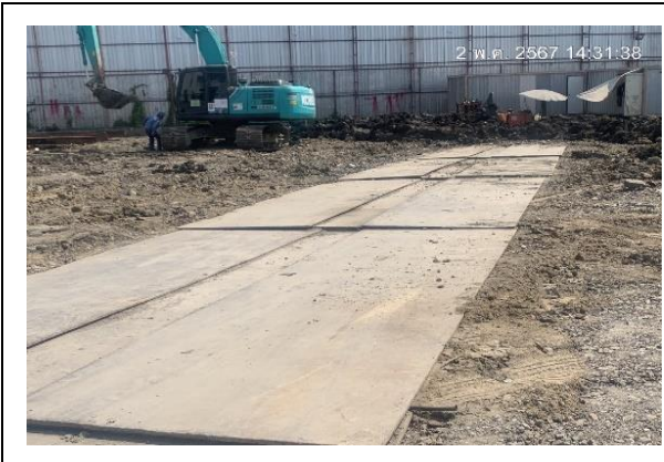
รูปที่ ก-15 แผ่นเหล็กอย่างหนา ปูบริเวณภายในพื้นที่โครงการ
