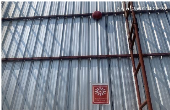
รูปที่ ก-45 เครื่องแจ้งเหตุเตือนเพลิงไหม้ ด้วยเสียง Alarm Bell
