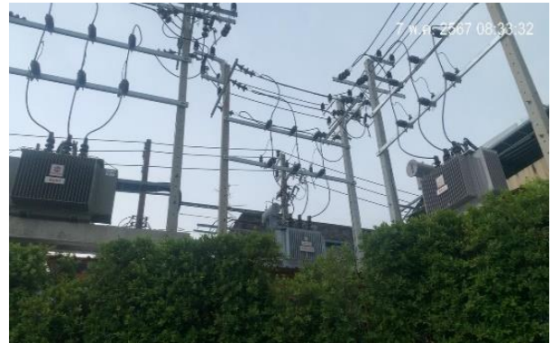
รูปที่ ก-39 หม้อแปลงไฟฟ้าในพื้นที่ก่อสร้าง
