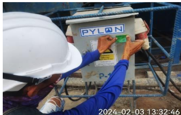
รูปที่ ก-40 การติดตั้งแผงควบคุมไฟฟ้า และอุปกรณ์ตัดกระแสไฟฟ้า
