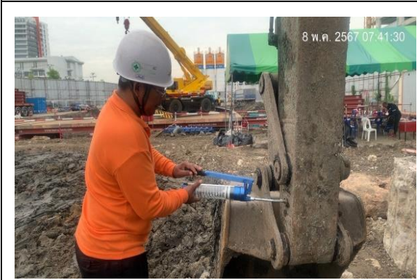
รูปที่ ก-19 ใช้น้ำมันหล่อลื่นช่วยลดการเสียดสี ระหว่างชิ้นส่วนของเครื่องจักร
